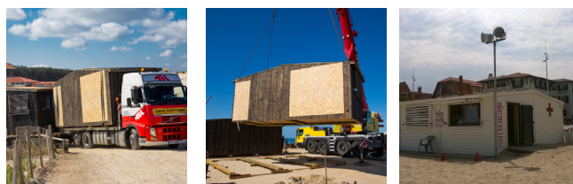
Acheminement du poste prototype vers Biscarrosse Pose du premier poste de secours en bois mobile à l'aide d'une grue Poste de secours de la plage d'Hendaye
